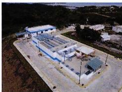
Ilustración 4 Plan de tratamiento de agua potable de Pedernales
